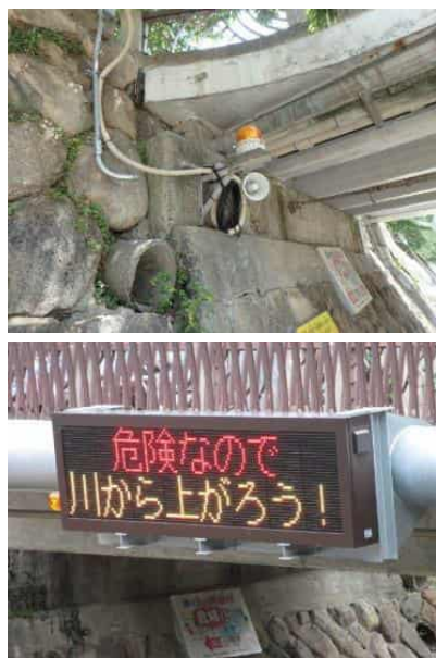
河川利用者への注意喚起を目的とした増水警報施設等の整備事例（都賀川）
