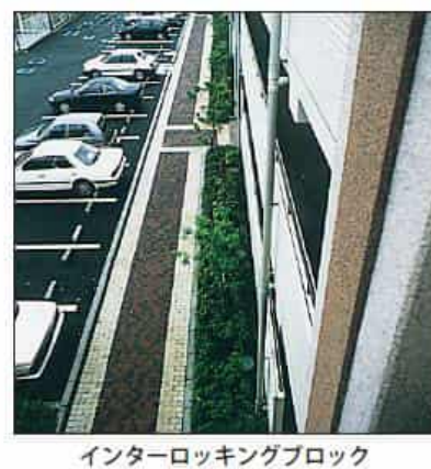
図 3.2.8 駐車場、歩道での浸透の例（千葉県柏市）
