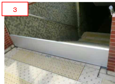
図 3.3.19 止水板の設置（デュオこうべ）
