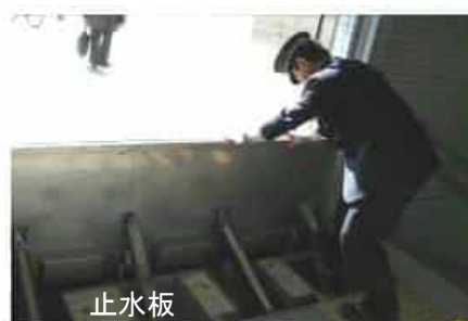
図 3.3.18 止水板、止水鉄扉の設置（神戸市営地下鉄）
