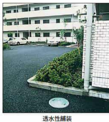
図 3.2.8 駐車場、歩道での浸透の例（千葉県柏市）
