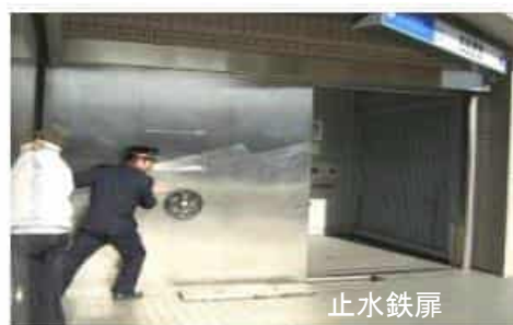
図 3.3.18 止水板、止水鉄扉の設置（神戸市営地下鉄）
