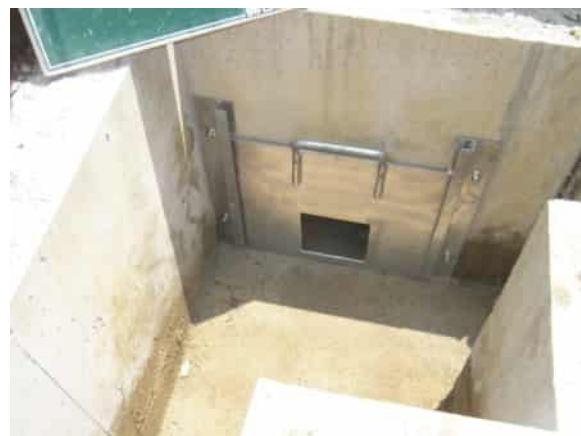
図 2.2.1 真陽小学校における流出調整機能施設(オリフィス)の整備
