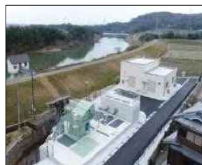
安取雨水ポンプ場(加東市) 平成31年2月完成
