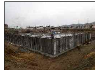
糸引公園雨水貯留施設(姫路市) 令和元年7月完成
