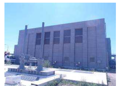
● 小野浜ポンプ場
