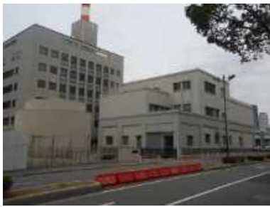
● 中突堤ポンプ場
