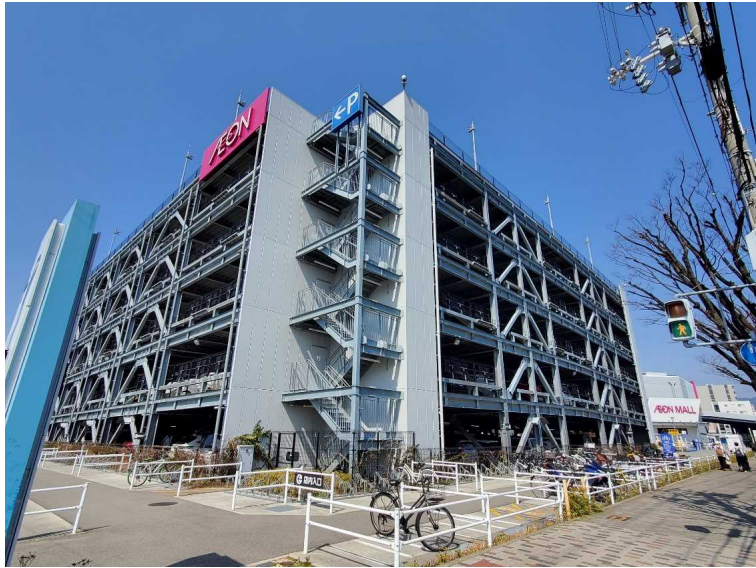
イオンモール神戸南 駐車場 (1階の柱10本が貯水柱)
