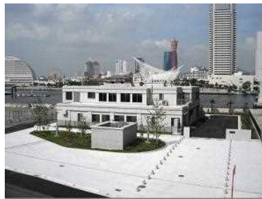
● 京橋ポンプ場
