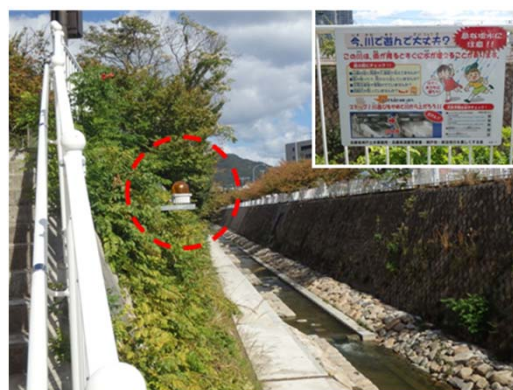
増水警報装置（妙法寺川）
