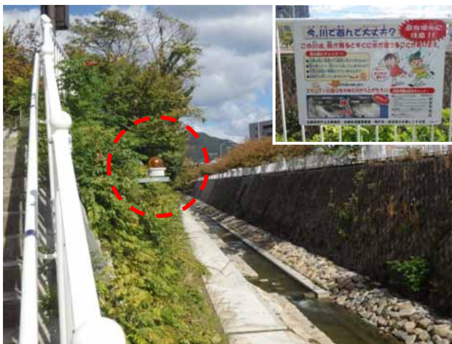
図 7.2.1 回転灯の設置 (妙法寺川)
