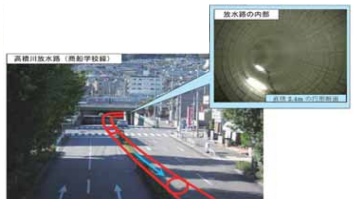
図 2.4.1 高橋川放水路
