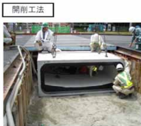
図 5.2.3 雨水幹線の整備 (神戸アクアプラン 2015)
