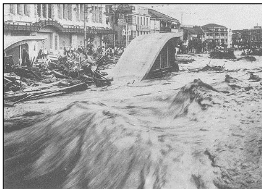
三宮そごう前（現フラワーロード） を流れる濁流
