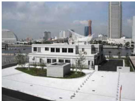
図 2.4.18 京橋ポンプ場
