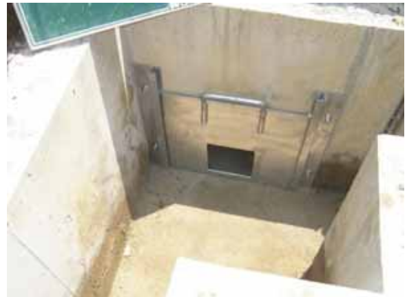
図 2.5.1 真陽小学校における流出調整機能施設(オリフィス)の整備
