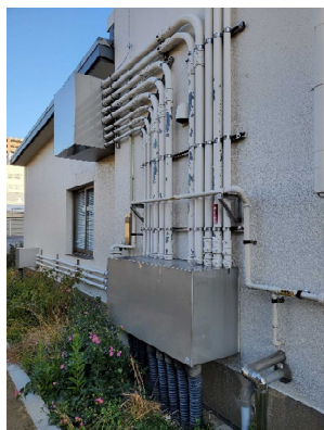
重要施設（電気設備）の浸水対策イメージ
