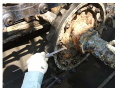
施設の劣化状況（左：送泥管の腐食 右：最終沈殿池設備の固着）
