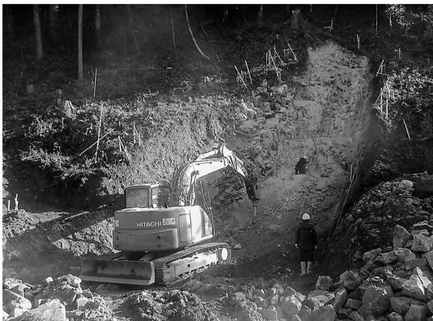
砂防堰堤の基礎工事。この後、強固なコンクリートを打設する
