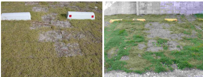
締め固め不足により張芝が活着せず、張芝単位で枯損した事例
