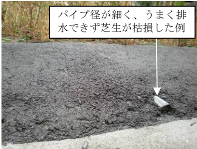
排水パイプからうまく排水できず枯損した例
