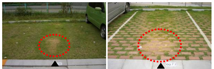
エンジン熱の影響（後ろ向き駐車区画）
