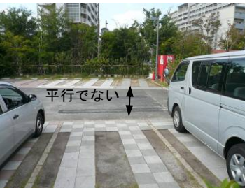
タイヤ圧等で枯死した例
