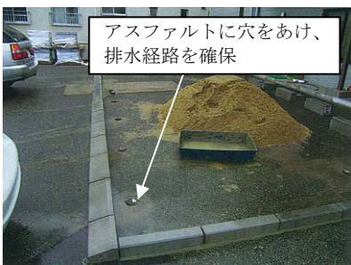
アスファルト上に直接施工するため、アスファルトに排水用の穴をあけた例
