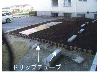
ドリップチューブを設置した事例
