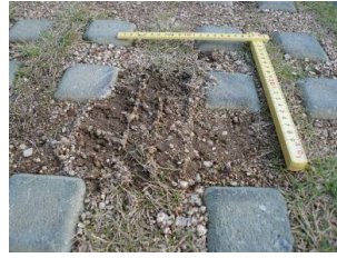
ブロック間隔が9cm程度と広く、土にタイヤの跡が残る事例
