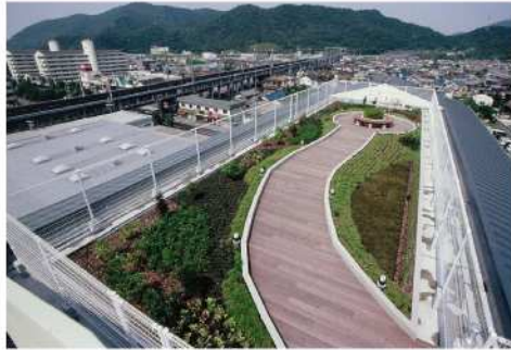
写真-17（整備直後の屋上庭園）
