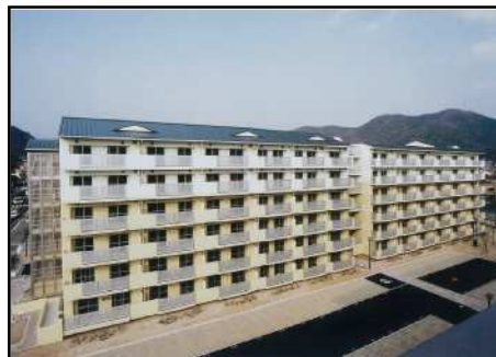
写真-4（更新された建物・設備）
