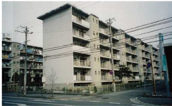
写真-1 (建物・設備の老朽化が進んでいる)
