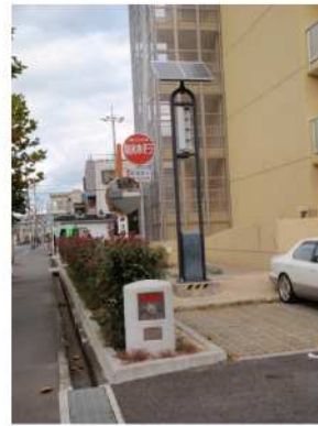
写真-19（太陽光・風力一体型外灯）
