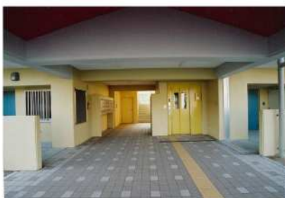
写真-11 (エレベーター設置・共用ホール)
