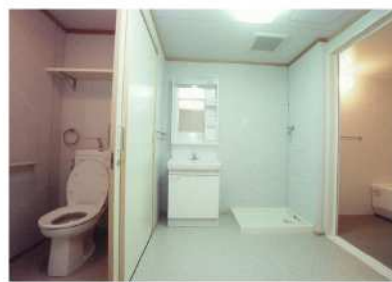
写真-10 (浴室・洗面・便所：手摺設置、段差なし、給湯)
