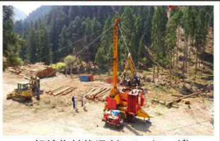
架線集材状況(タワーヤーダ)
