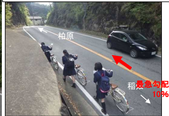
③路肩狭小、急勾配で通学生が危険
