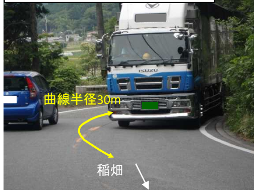
②大型車が路肩にはみ出し
