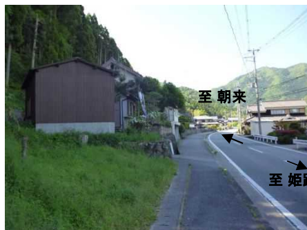
③保全対象(県道長谷市川線)
