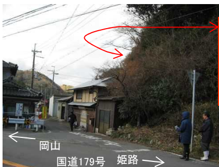
③保全対象とがけの状況
