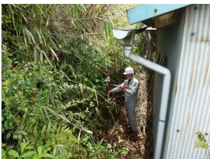
②斜面状況
