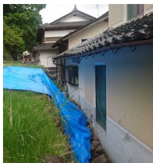
③斜面状況(人家裏)
