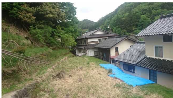
②斜面状況(崩壊状況)
