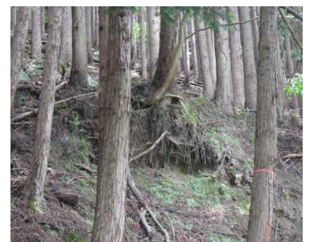
④斜面状況(オーバーハング)
