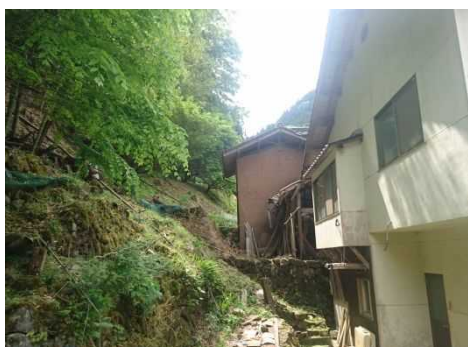
②斜面状況(人家裏)と保全対象の状況
