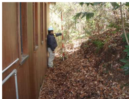
③保全対象とがけの状況
