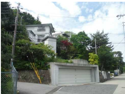
②保全対象とがけの状況
