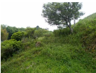
②斜面状況
