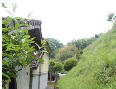
③保全対象とがけの状況
