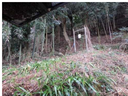
②斜面状況(人家裏)
