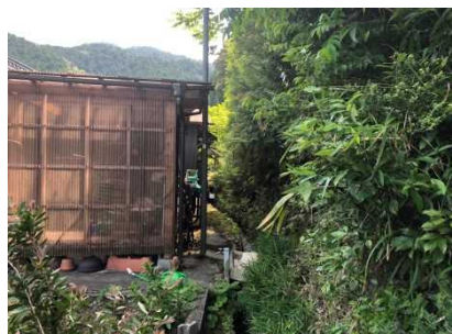
③保全対象とがけの状況
