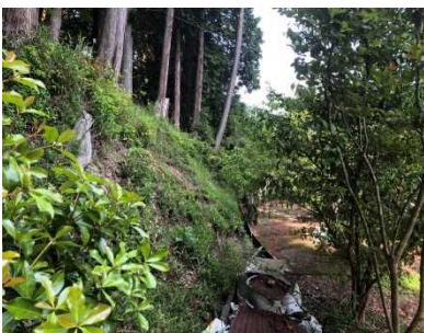
②斜面状況(人家裏)
