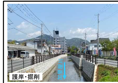
②完成区間(柳橋上流)
