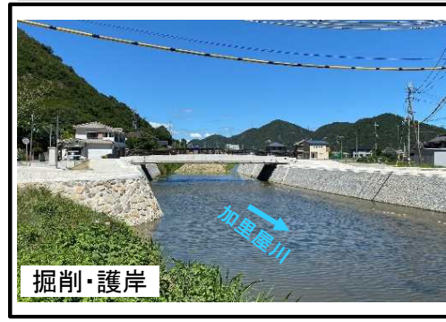
③事業中区間(砂子橋周辺)
