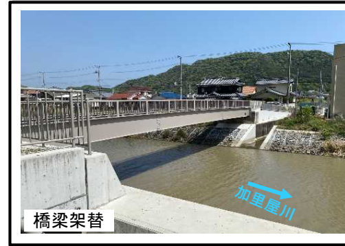
②完成区間(人道橋)
