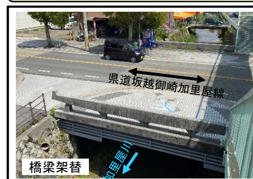
④残事業区間(加里屋橋)
