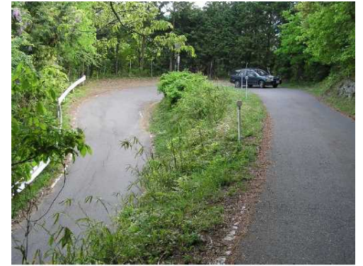
②幅員狭小な現道(離合困難)
