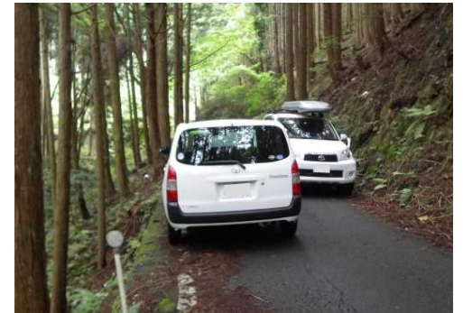
③幅員狭小な現道(冬期の通行)
