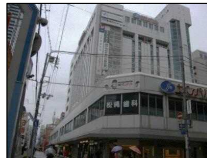
②施設の耐震性不足
