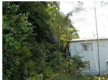
③保全対象の状況
