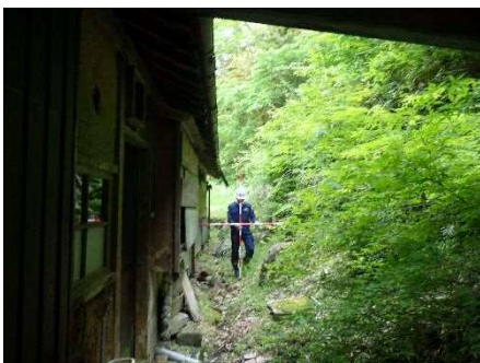
② 保全対象とがけの状況
