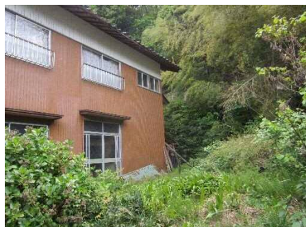
③ 保全対象とがけの状況
