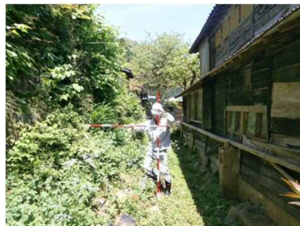
③保全対象とがけの状況
