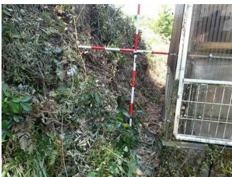
②斜面状況(人家裏)
