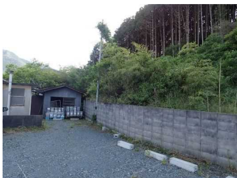
③保全対象とがけの状況
