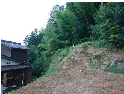
②保全対象とがけの状況(人家裏)
