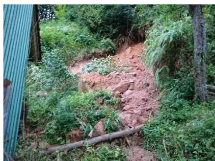
③斜面状況(人家裏)
