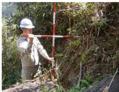
③保全対象とがけの状況
