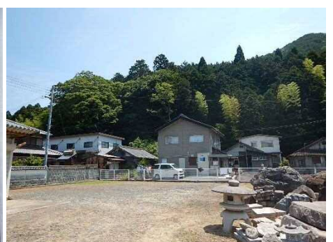
④保全対象の状況
