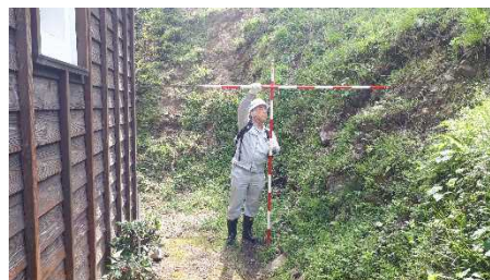
③保全対象とがけの状況
