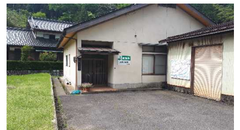
④保全対象(避難所)
