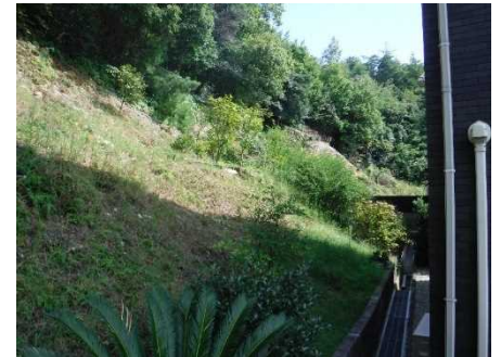
④保全対象とがけの状況
