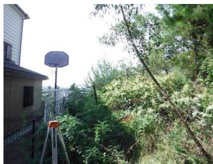
③保全対象とがけの状況
