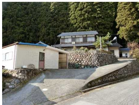
③保全対象(人家)
