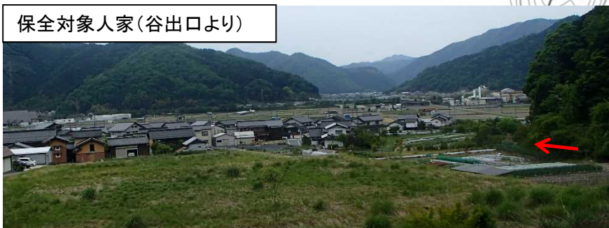
溪流荒廃状況
