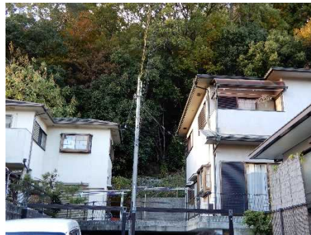
③ 保全対象(人家)
