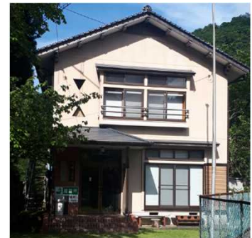
④ 保全対象(避難所)
