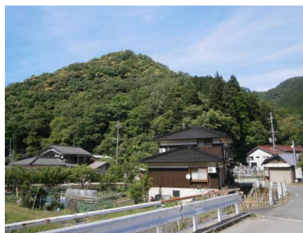
③保全対象とがけの状況
