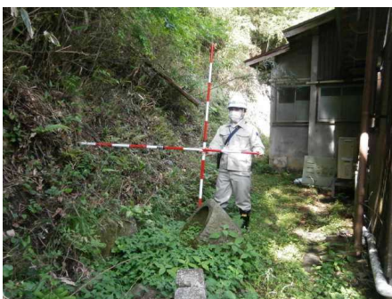
②保全対象とがけの状況
