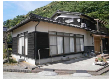
④保全対象(人家)
