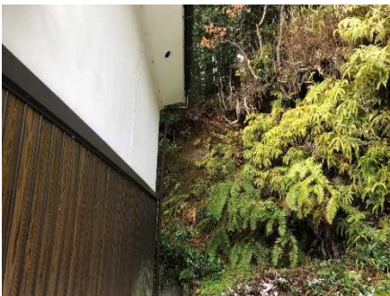
②斜面状況(人家裏)
