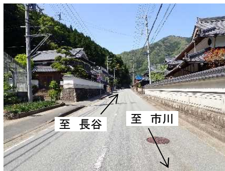
③保全対象(県道長谷市川線)
