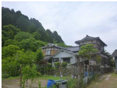
③保全対象(人家)
