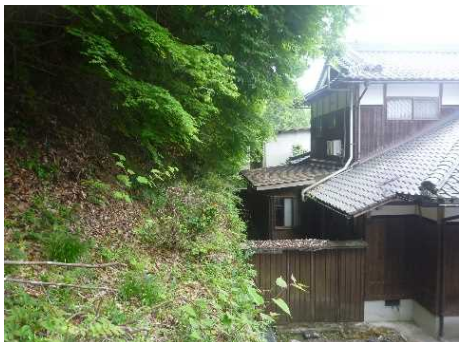
②保全対象とがけの状況
