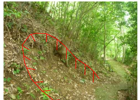
④荒廃状況
