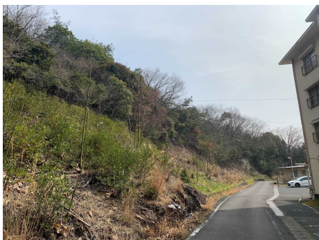
②保全対象とがけの状況
