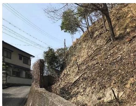
③保全対象とがけの状況
