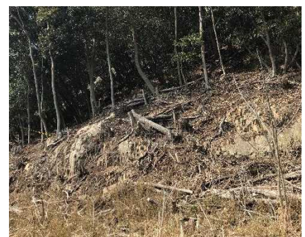
④斜面状況
