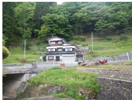
③保全対象(人家)
