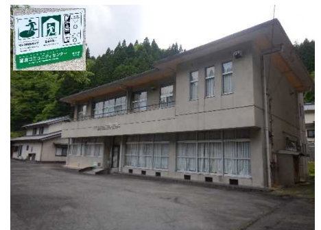
④保全対象(避難所)
