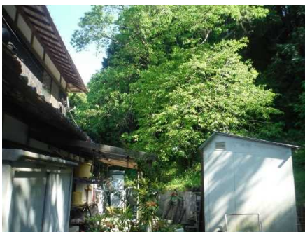
② 保全対象とがけの状況
