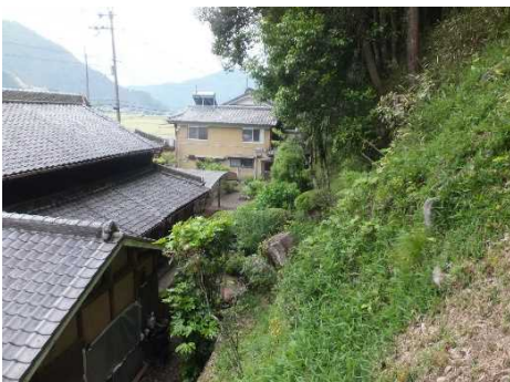
② 保全対象とがけの状況
