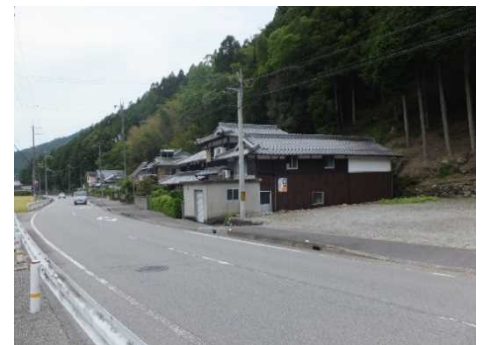
④ 保全対象(人家)
