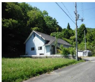
③保全対象(人家)
