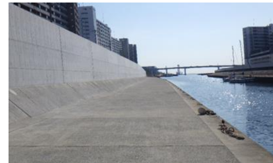
尼崎西宮芦屋港海岸(西宮市)
