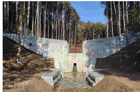
下母子谷川 砂防堰堤 (三田市)
