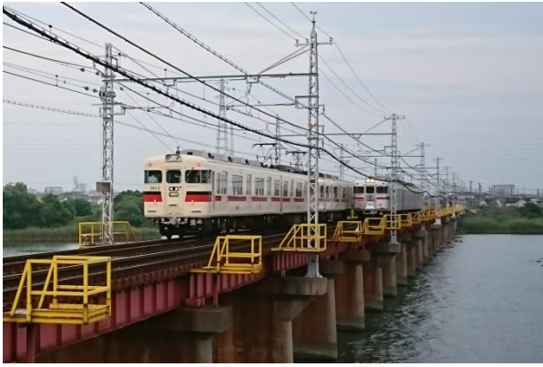
山陽電鉄加古川橋梁
