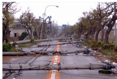
図 4.1 倒壊した電柱による道路閉塞 (出典：国土交通省 HP)
