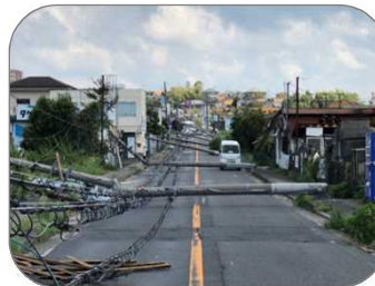
ア 倒壊した電柱による道路閉塞 (平成30年台風21号 大阪府泉南市)
