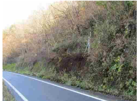
写真1 土砂災害警戒区域
